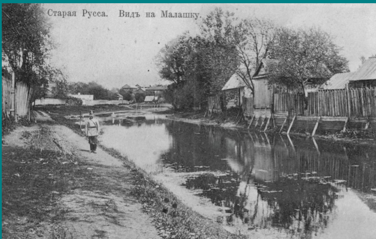
Вид на реку Малашку и прибрежную застройку
